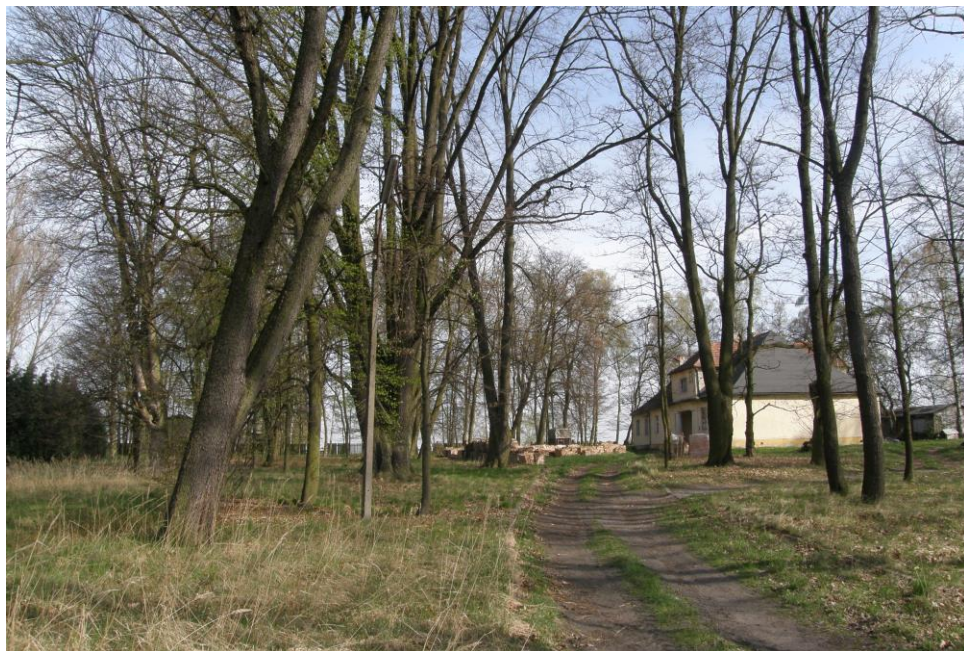
Widok od strony południowej
