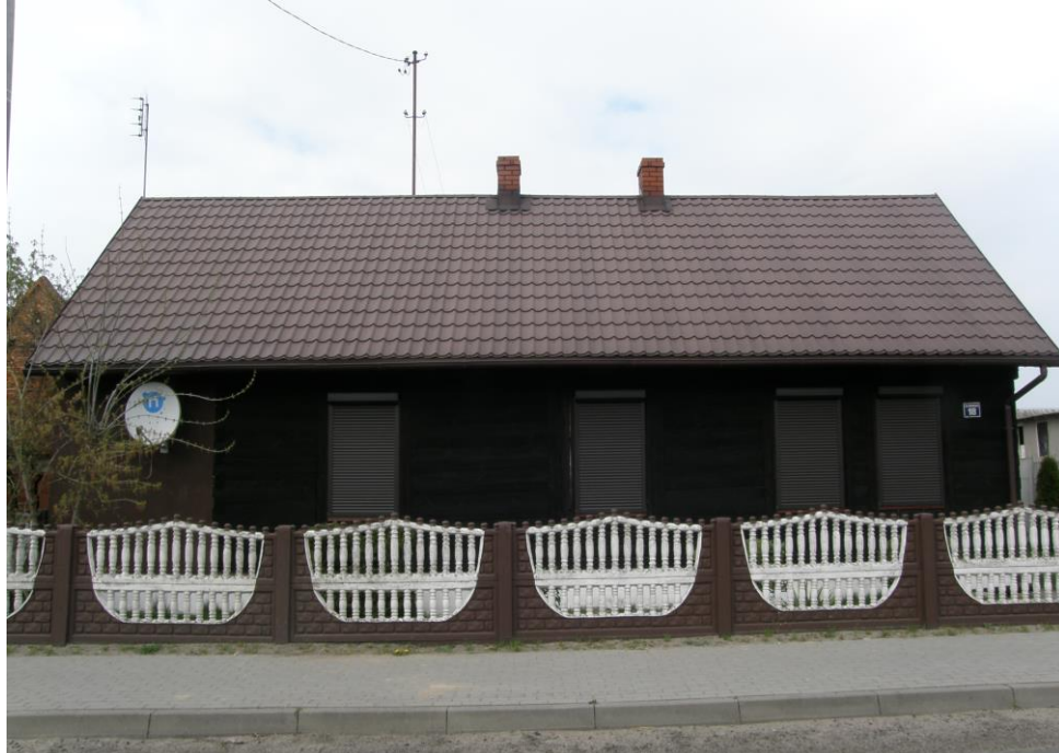
Widok od strony południowej
