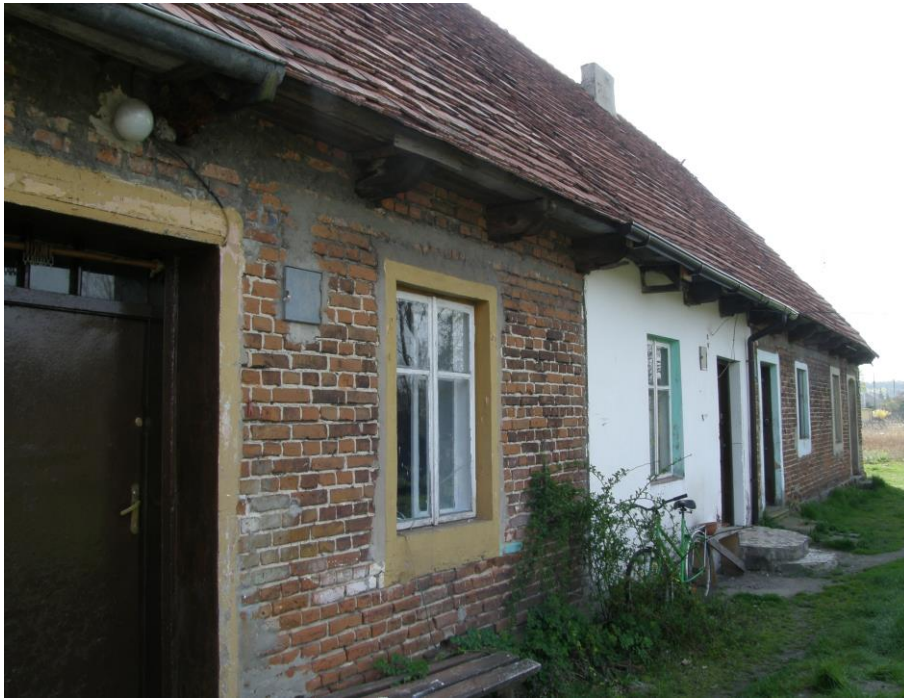
Widok od strony zachodniej
