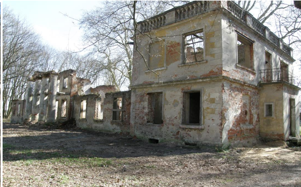
Widok od strony północno-zachodniej
