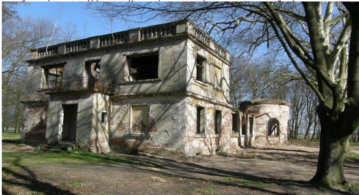
Widok od strony południowo-zachodniej
