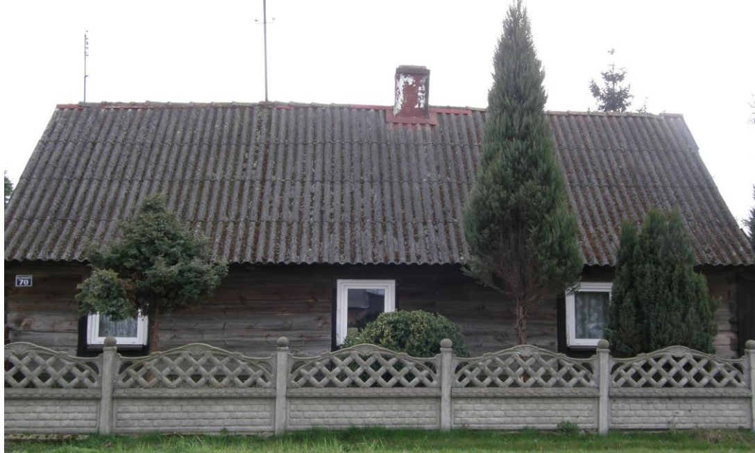
Widok od strony północnej
