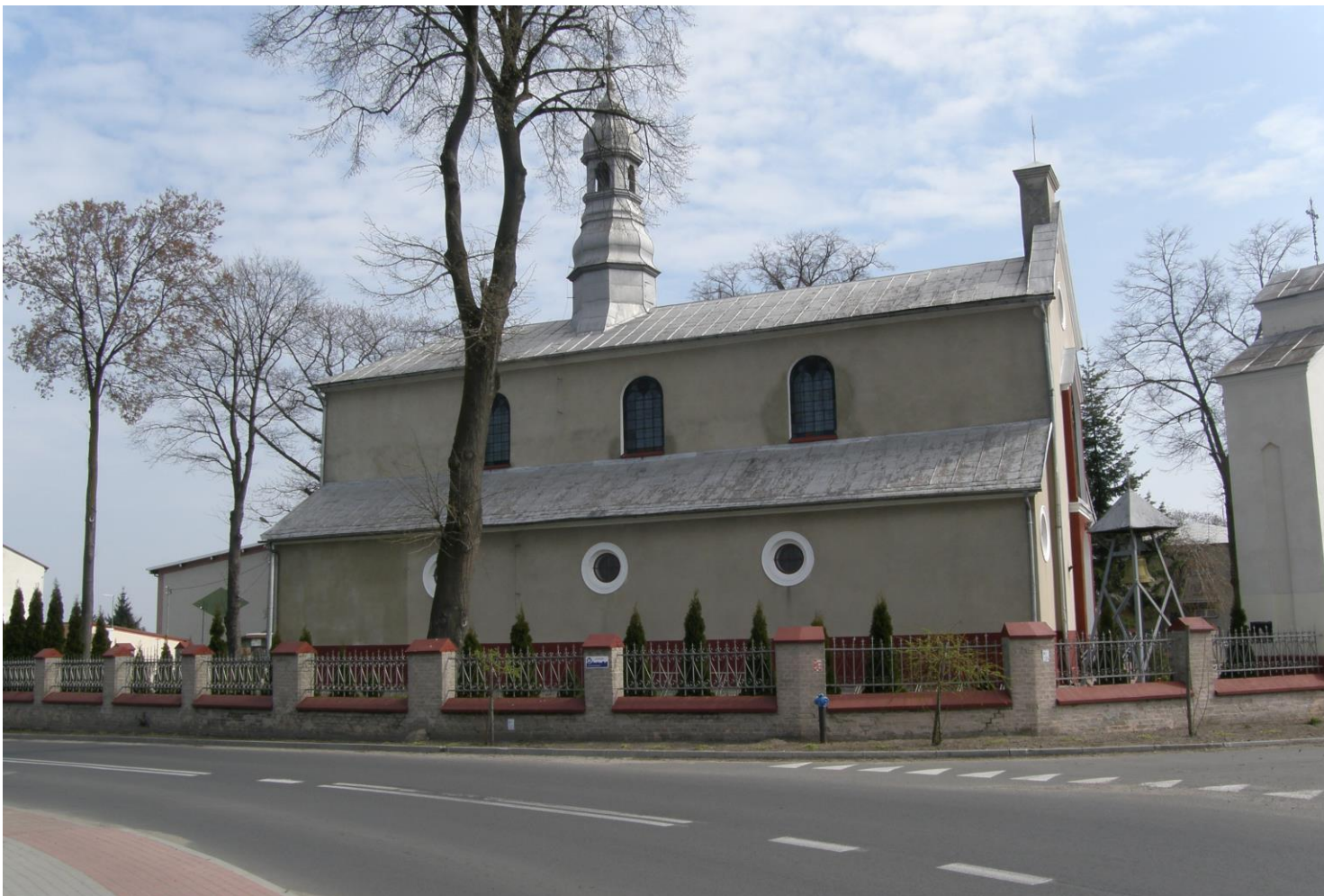
Widok od strony zachodniej
