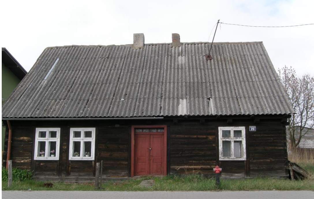
Widok od strony południowej
