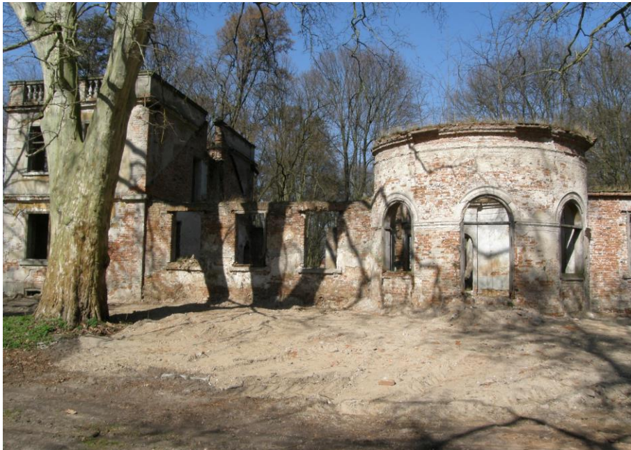
Widok od strony południowej
