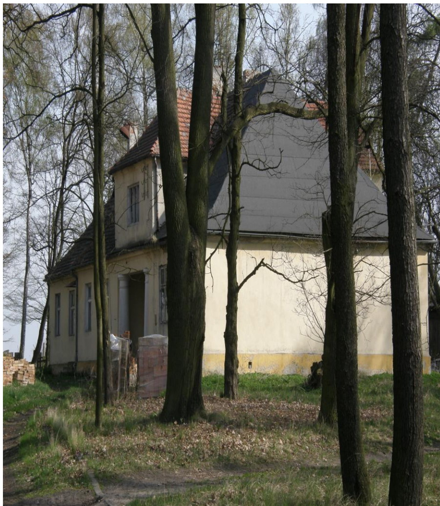
Widok od strony południowej
