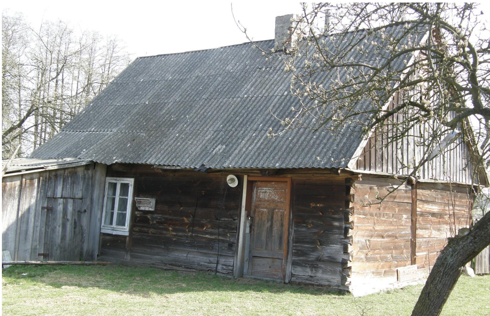
Widok od strony południowo-zachodniej
