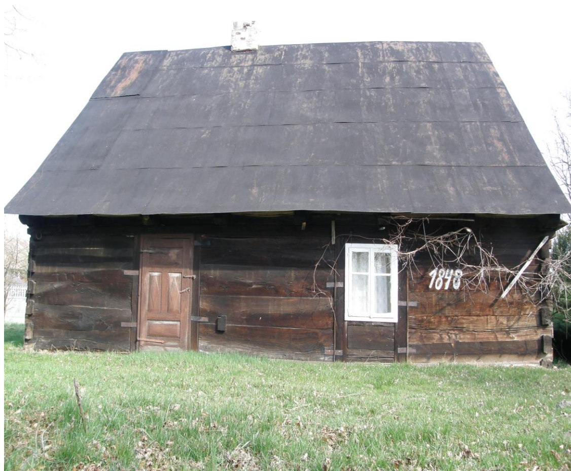
Widok od strony zachodniej
