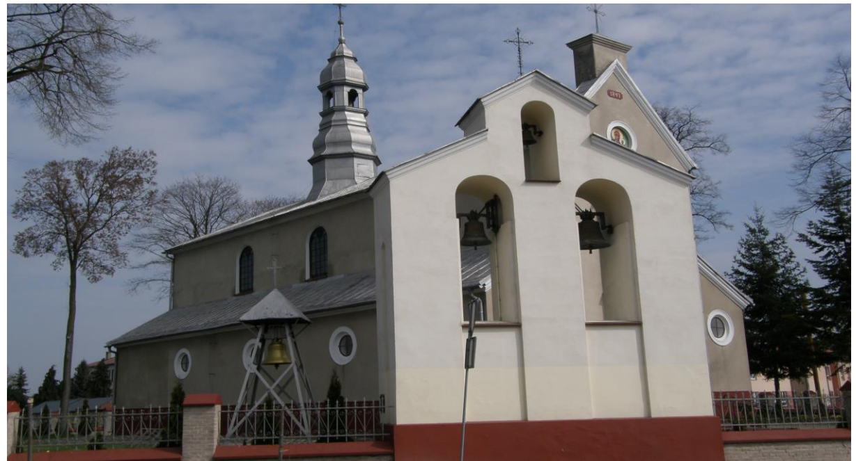
Widok od strony południowo-zachodniej
