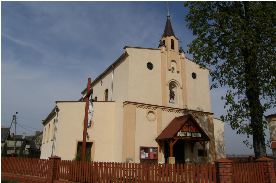
Widok od strony południowo-wschodniej
