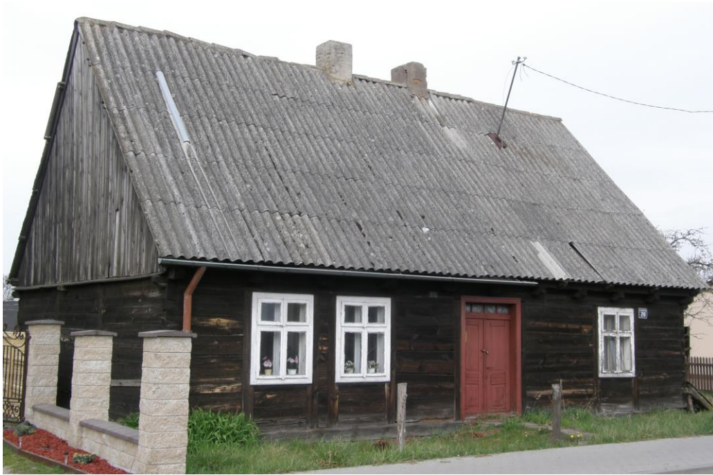
Widok od strony południowej
