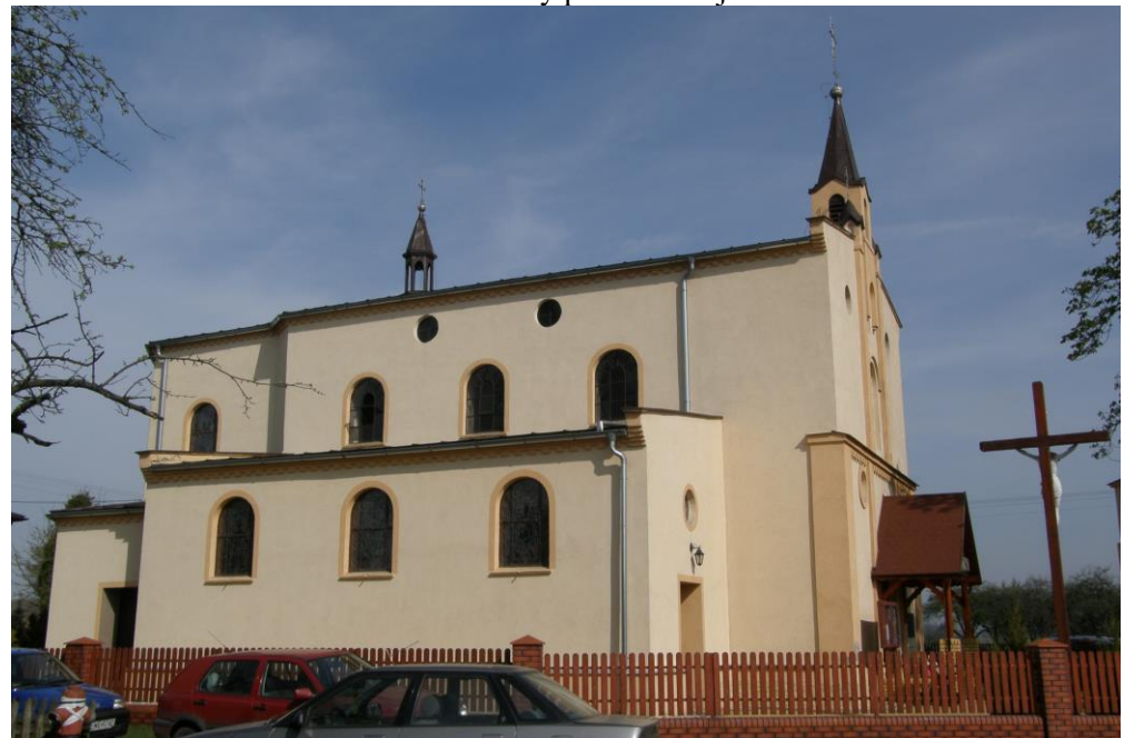
Widok od strony południowej
