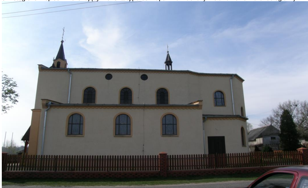
Widok od strony północnej
