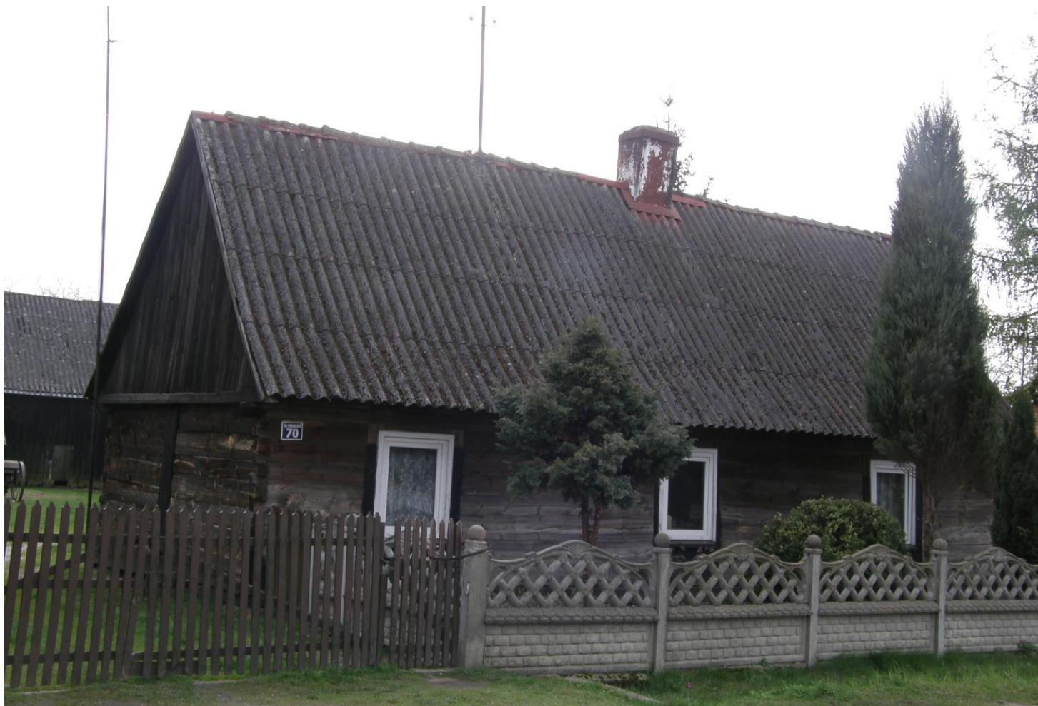
Widok od strony północnej
