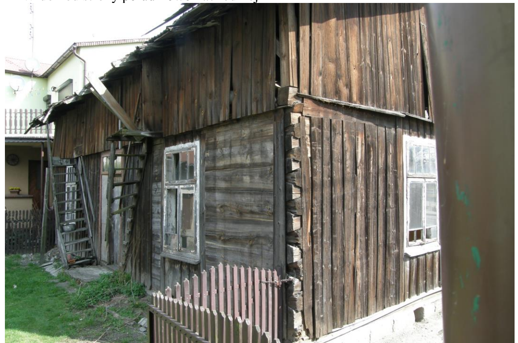
Widok od strony południowo-zachodniej
