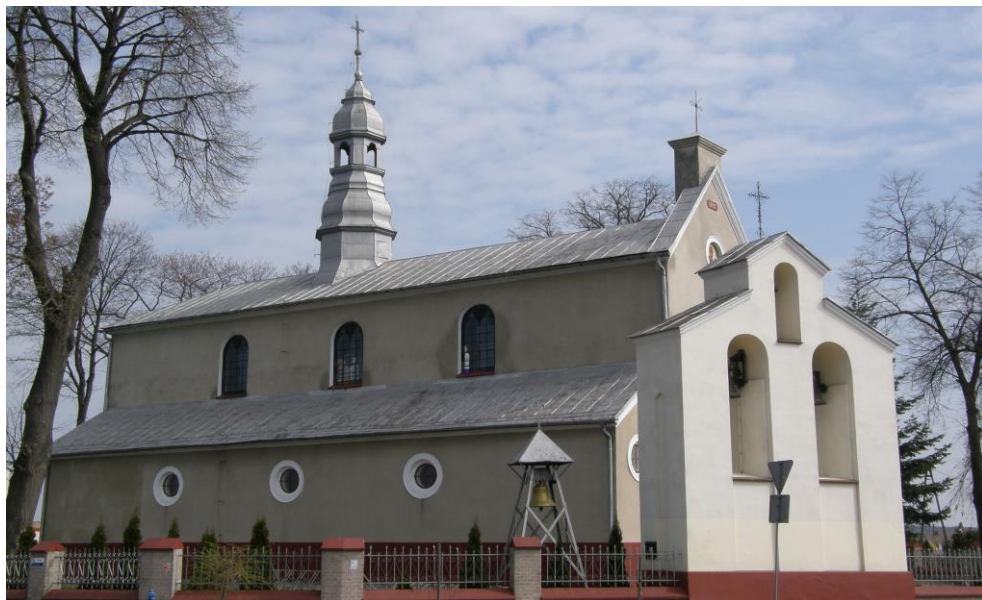
Widok od strony południowo-zachodniej
