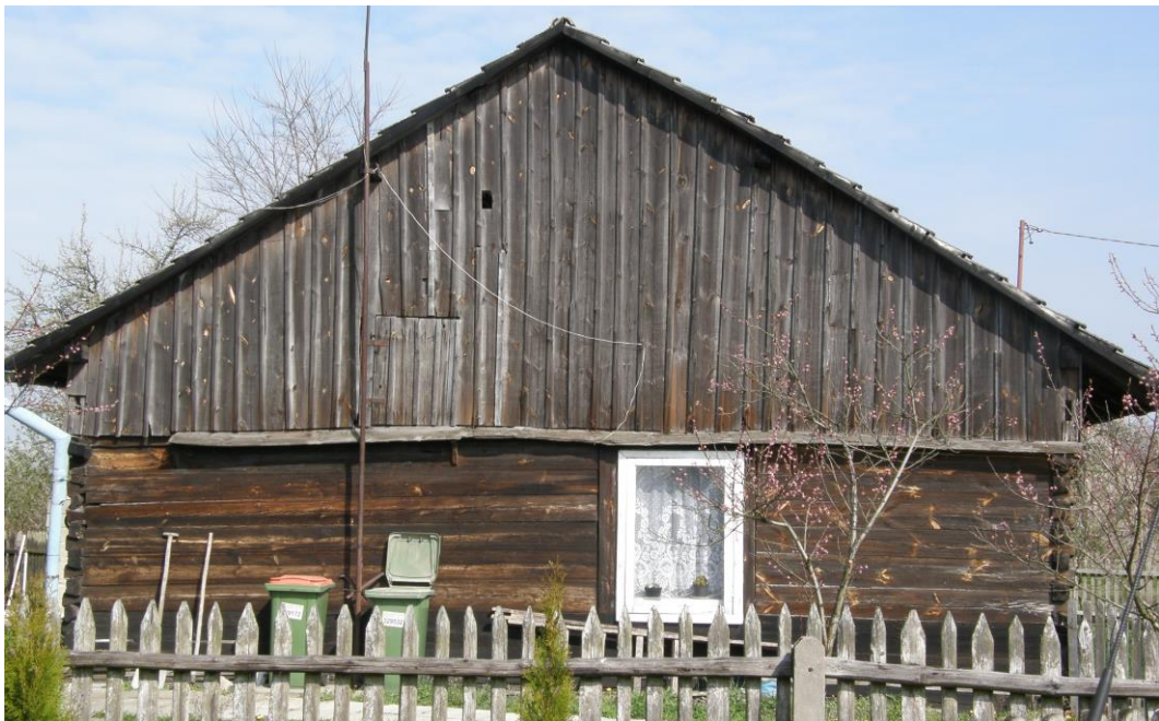
Widok od strony południowo-zachodniej
