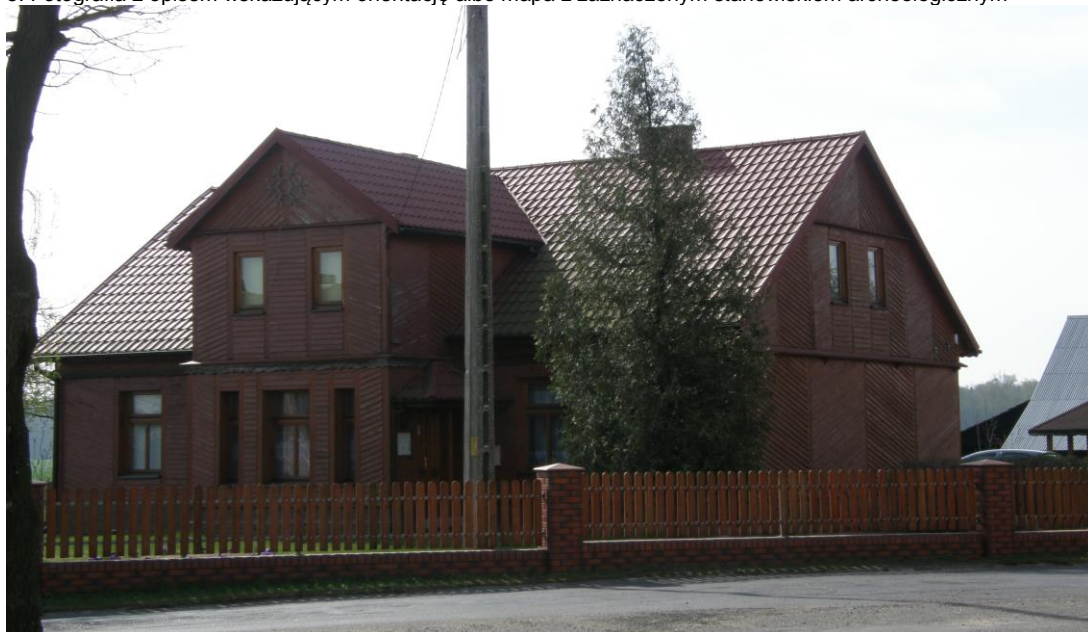
Widok od strony północno-zachodniej
