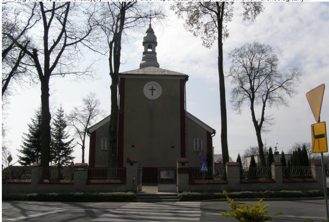
Widok od strony północnej
