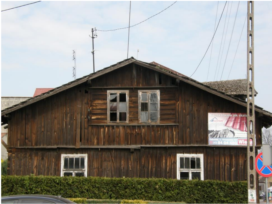
Widok od strony południowej
