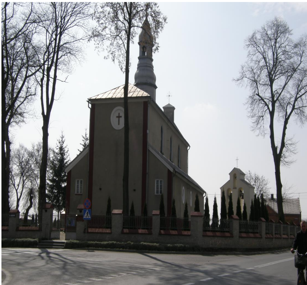
Widok od strony północnej
