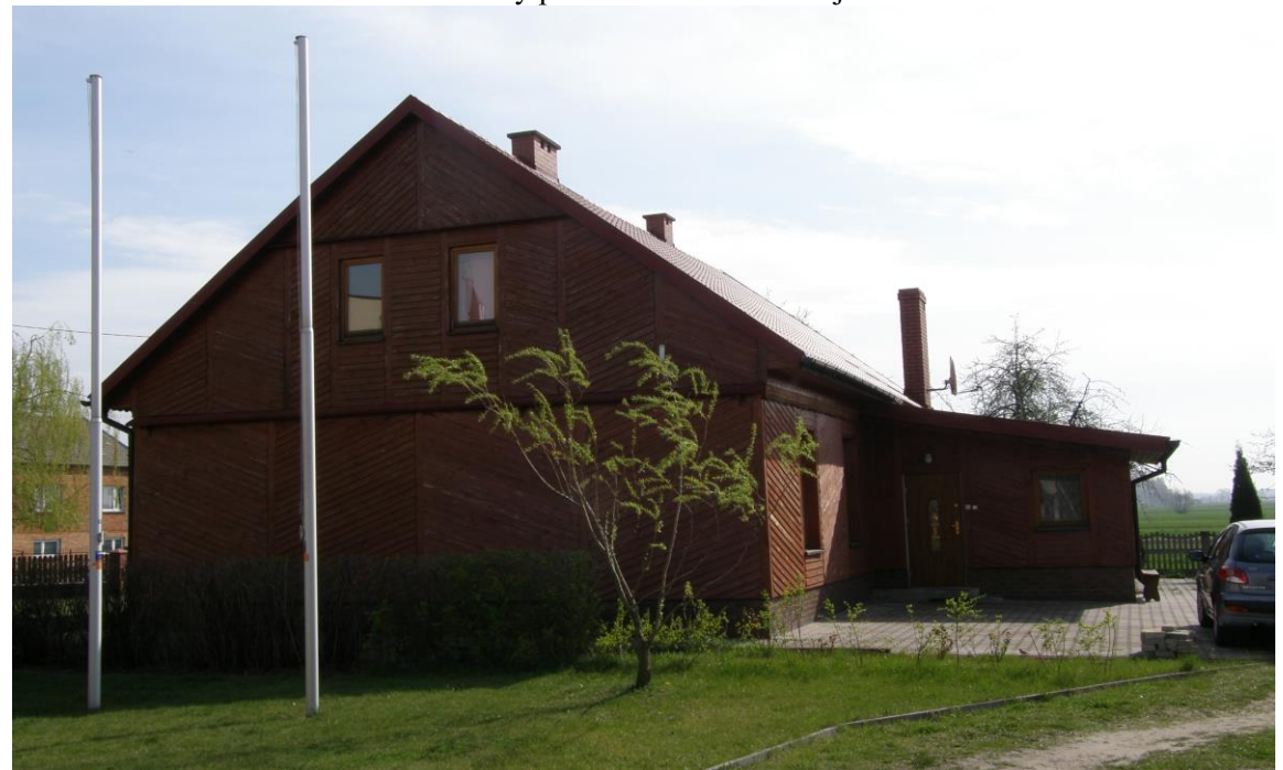
Widok od strony południowo-zachodniej
