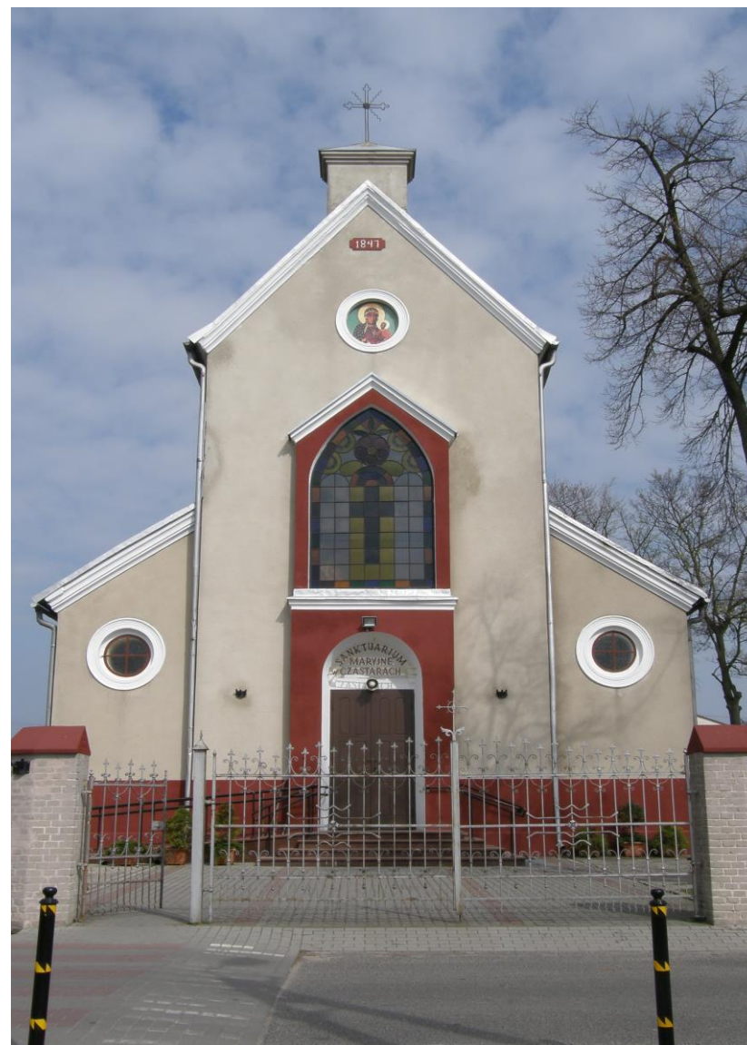
Widok od strony południowej
