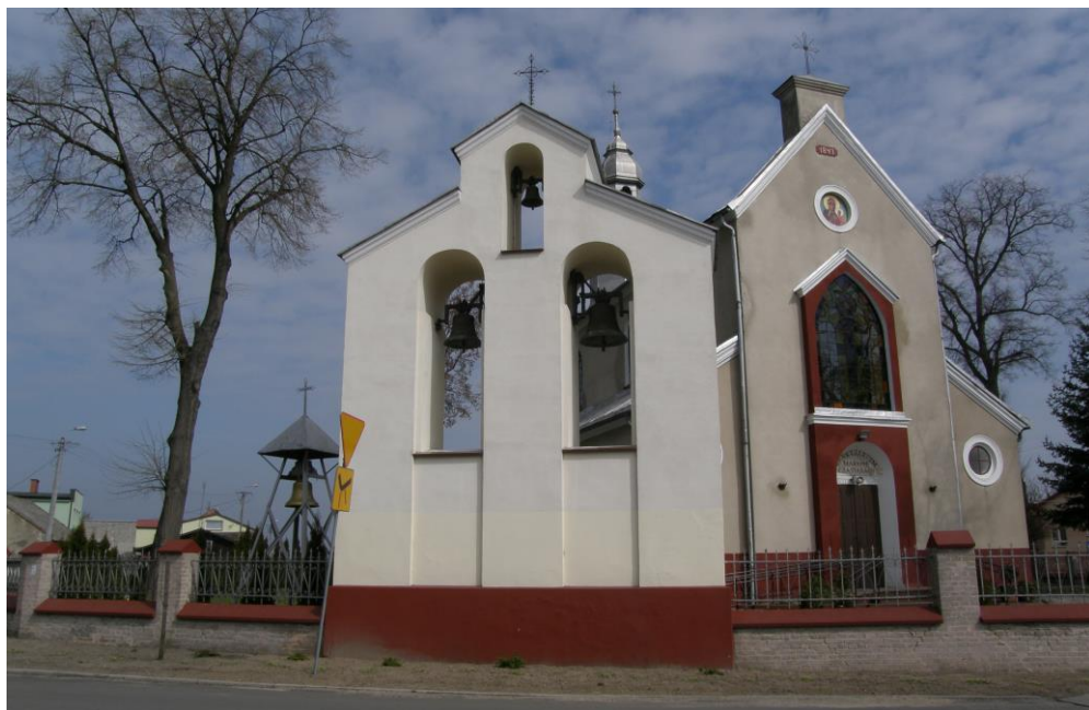
Widok od strony południowej
