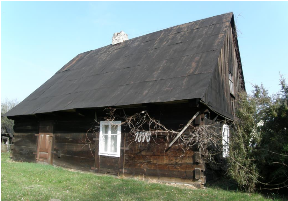
Widok od strony południowo-zachodniej
