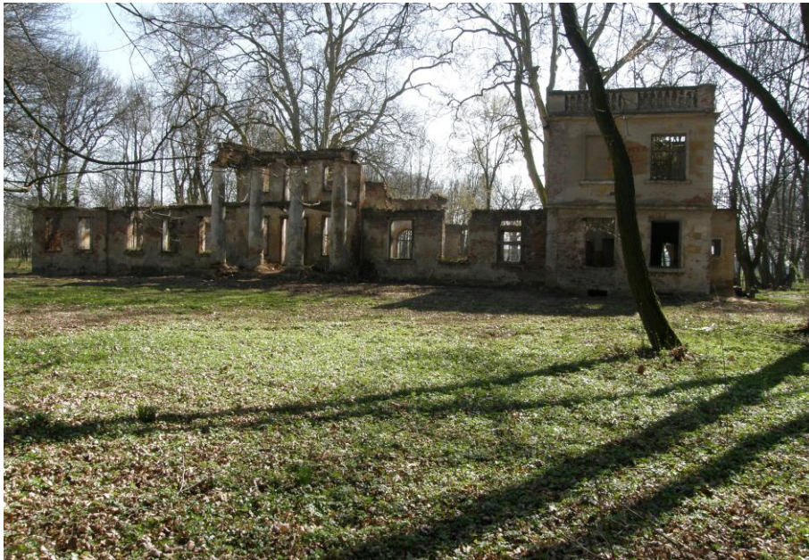
Widok od strony północnej
