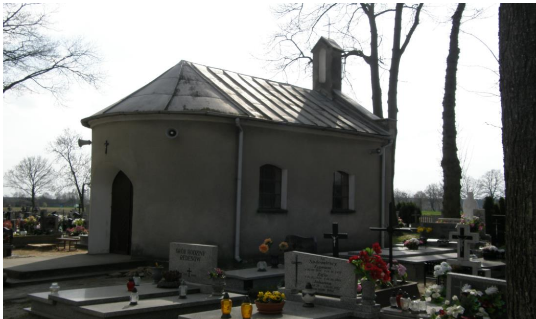
Widok od strony północno-zachodniej
