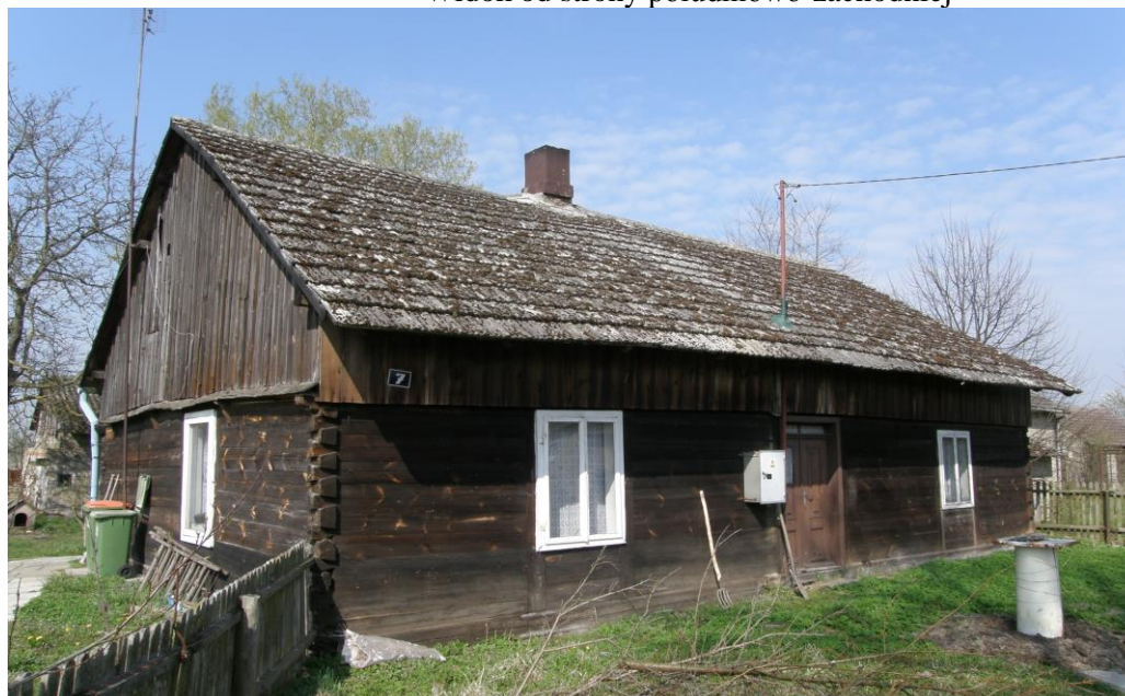
Widok od strony południowo-zachodniej
