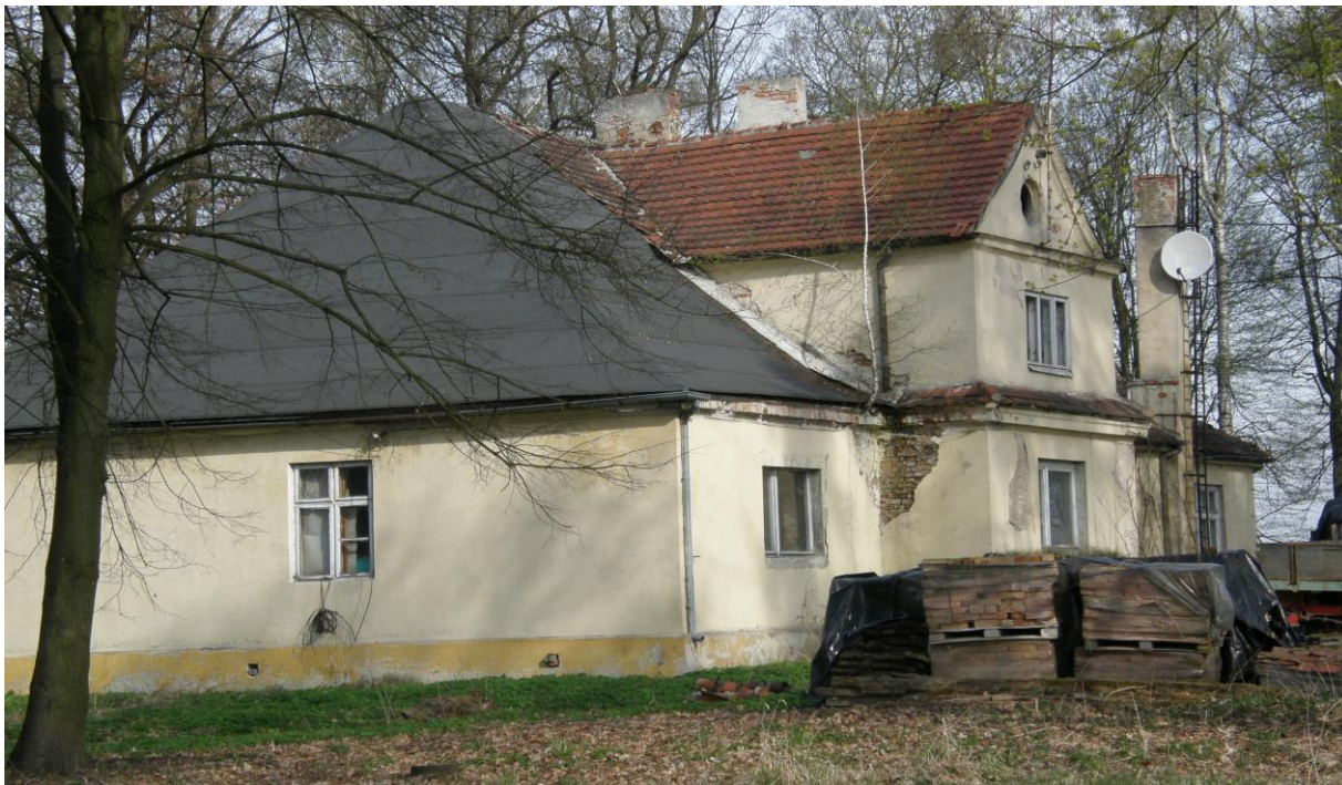
Widok od strony północno-zachodniej
