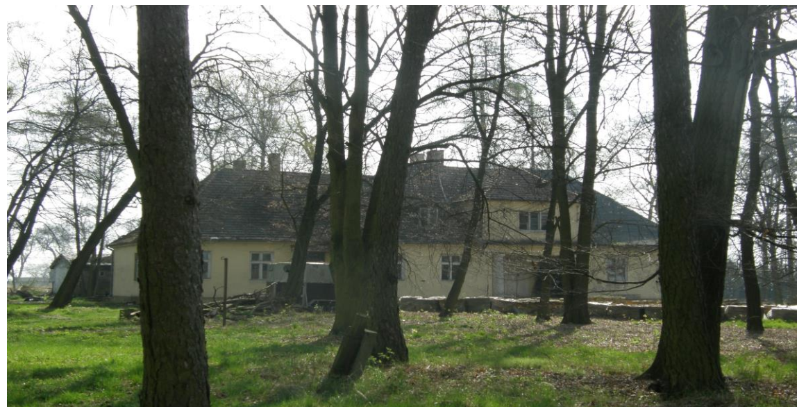
Widok od strony zachodniej
