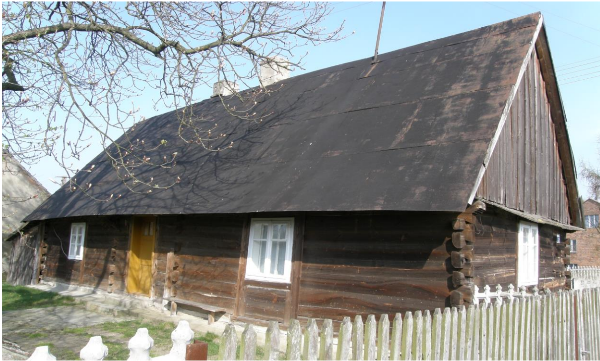
Widok od strony południowej
